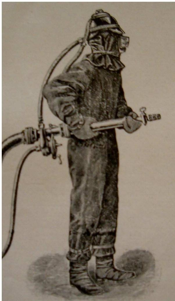
Hadicový přístroj s dmychadlem poháněným vodou od proudnice. (Odpadová voda z dmychadla proudí do rozstřikovací růžice na přilbě a vytváří ochrannou clonu proti žáru.)
